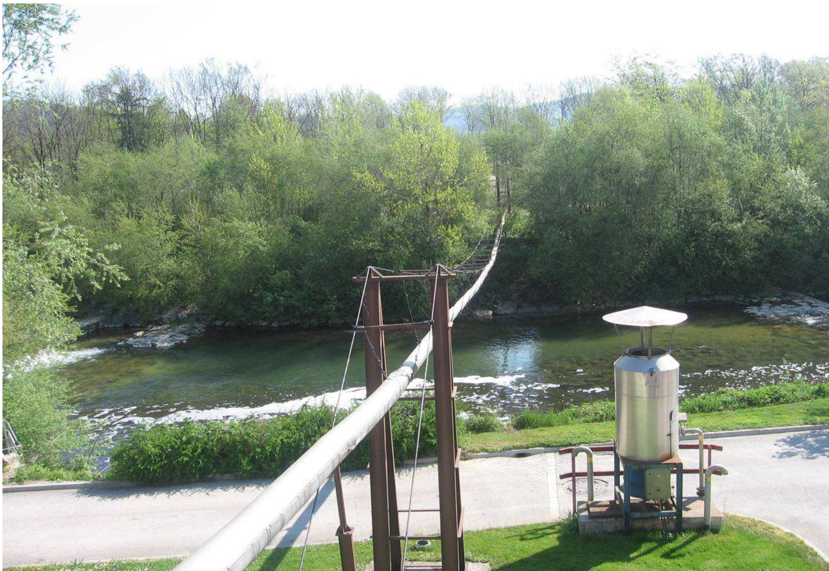
Cevovod, ki pripelje gnojevko na čistilno napravo
